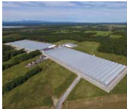
巨大ハウスに約14万苗を定植。敷地内には脱石油型エネルギー供給施設、苗生産施設も
