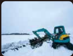
ビニールの表面ギリギリまで機械で掘る熟練の技
