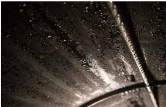
気密性が高く水分が蒸発しないトンネル内部。午後になり気温と湿度が上昇すると、天井にはびっしり結露が
